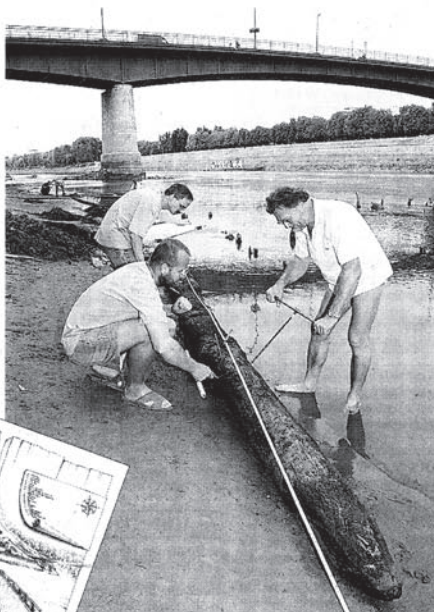
Kertész Róbert (guggol) és szakértő csapata 2003-ban azonosította a Tisza alacsony vízjárása miatt a folyó felszíne fölött kiemelkedő egykori török kori fahídmaradványokat. A Rotary szobrán az egykori cölöphíd vélhető szerkezete is látható lesz.
