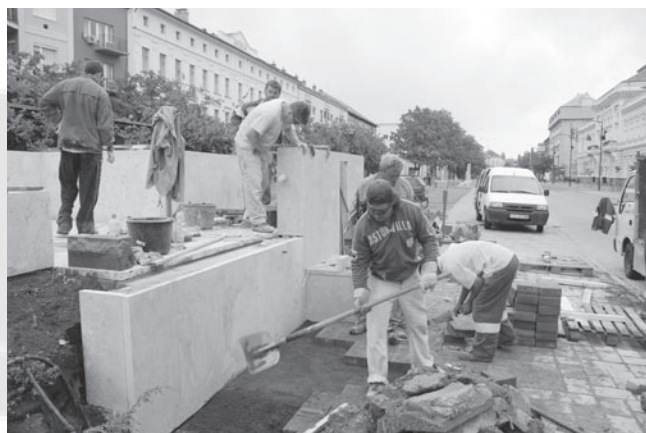
A burkolás és a járószint kivitelezésének befejezése
