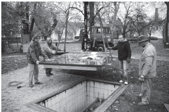
Közvetlenül az emlékkő mellett található a Tisza Szálló termálkútja, melynek fedése egy gránitlappal történt meg
