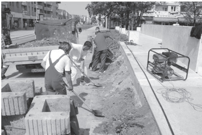
A munka a rézsű elbontásával kezdődött
