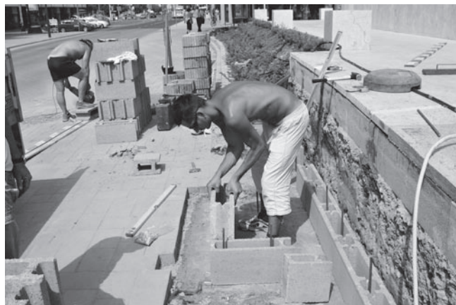
A posztamens építése
